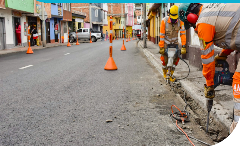
En Pamplona ejecutamos actividades de rehabilitación de pavimento y cunetas.
